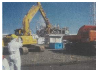
福島原発の復旧現場で稼働するラジコン建機
