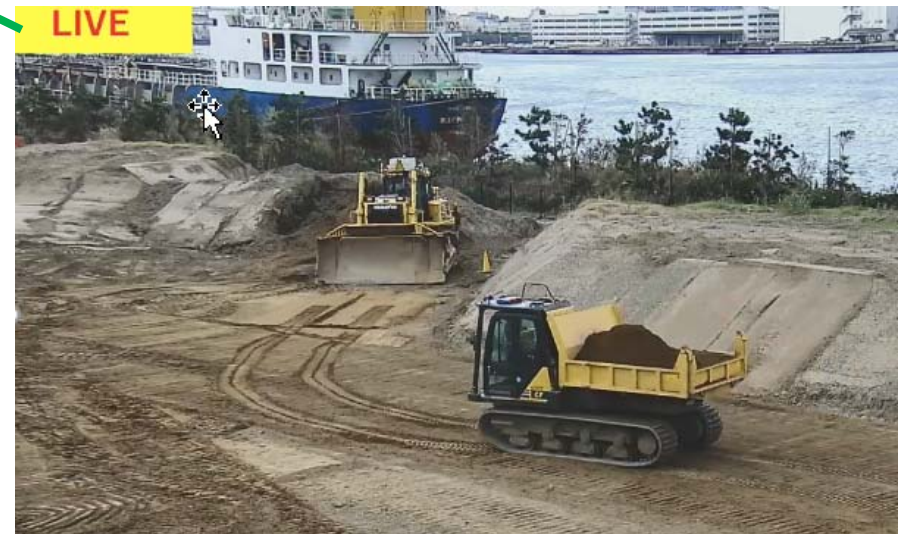
無人クローラダンプが土を運搬
