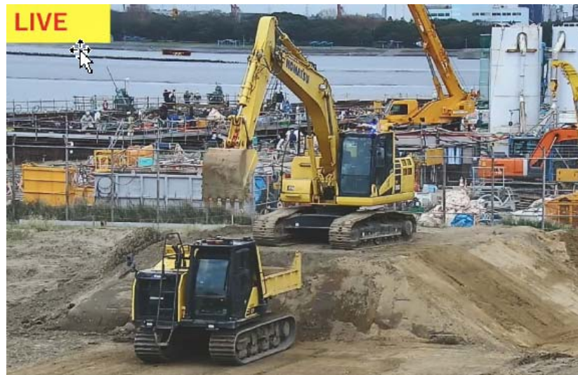
無人油圧ショベルが掘削・積み込み
