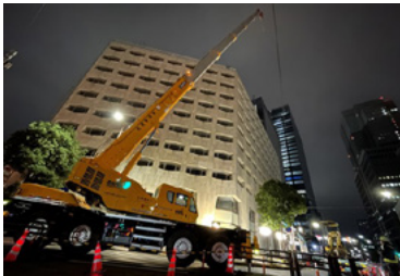
クレーンで搬出される樹木
