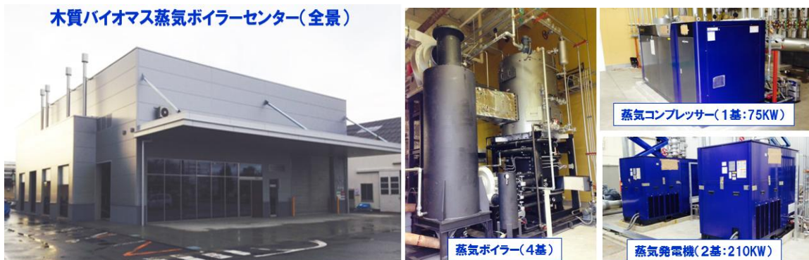
写真-8 プロジェクト B-② バイオマス発電導入例 (コマツ栗津工場 バイオマス蒸気ボイラシステム(2015年導入))
