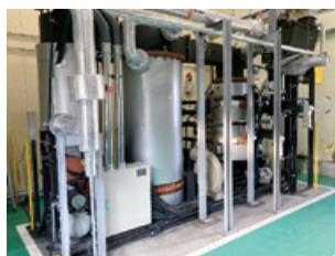
【茨城工場のバイオマスボイラー】 当社は、CO<sub>2</sub>排出削減のために再生可能エネルギーの導入を進めています。2015年には粟津工場で、地域の森林組合と協働したバイオマス・コジェネレーション・システムが本格稼働を開始しました。それに続き、2020年には、茨城工場でもバイオマスの活用を開始しました。含水率の低い良質な木質チップを燃焼し、その熱を溶接現場の空調に利用することで、従来の電気を使った空調から切り替え、バイオマス活用によるCO<sub>2</sub>削減を実現しました。使用する木質チップについては、茨城県森林組合連合会と連携し、県内で利用できていない間伐材を活用することで、持続可能なビジネスモデルとして地域林業の活性化に貢献しています。今後は、さらなるCO<sub>2</sub>排出量削減のため、木質チップをガス化した燃料を使って発電を行うバイオマスガス化発電設備の導入も計画しています。地域林業資源の活用促進を図るとともに、生産活動に使用する電力における再生可能エネルギーの割合を高め、CO<sub>2</sub>削減とESG課題解決への貢献を同時に進めていきます。
