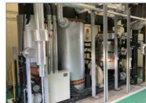
茨城工場のバイオマスボイラー
