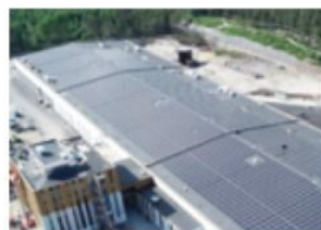
屋根一面に太陽光発電パネルを設置したコマツフォレスト新工場 (2021年8月竣工、スウェーデン・ウメオ)
