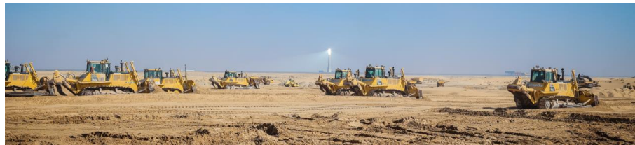
ICTブルドーザによる整地トライアル
