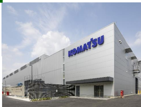
熱処理棟 外観
