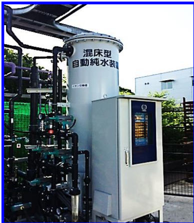
作業水浄化装置
