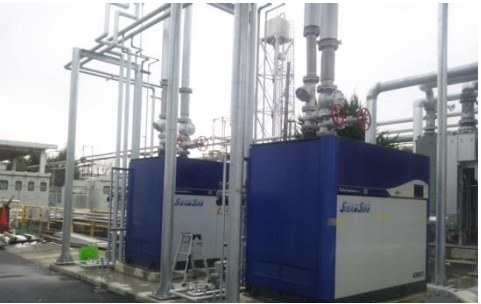
バイオマス発電&熱利用
