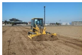
高精度均平化作業 (多機能ICTブルによる自動化で高精度均平化)
