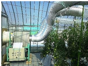
地下水冷却装置 夏季のトマトハウス冷却
