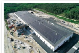
新工場および太陽光パネル
