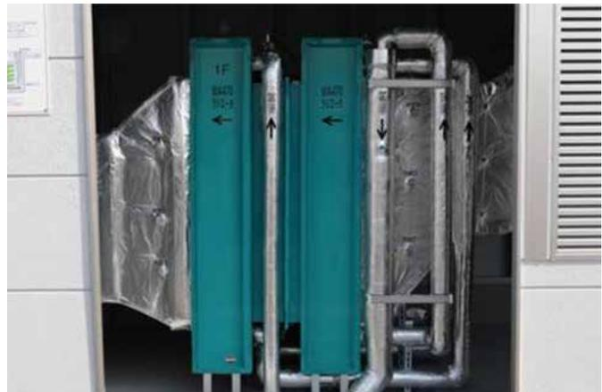
■ 地下水空調システム。コマツの建機で使用されている高効率ラジエーターを熱交換器に使用し、冷房には温度がほぼ年中一定（17℃）な伏流水を利用。冬季の暖房には構内設備の廃温水を利用しています。
