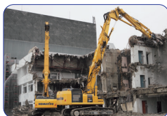
解体ロングフロント
