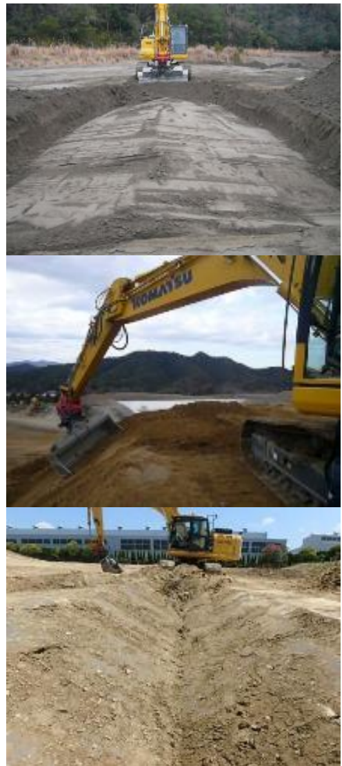
図9 オートチルトバケットを使用しての施工結果
