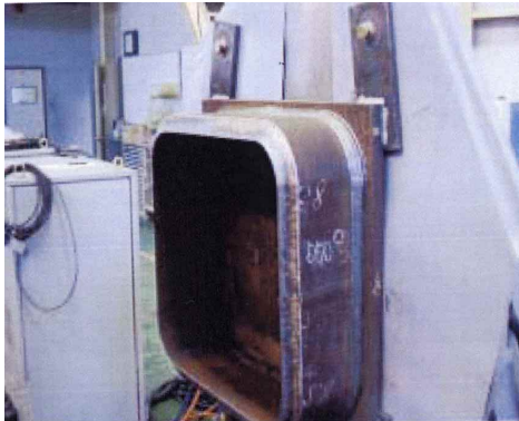
図7 コラム材の切断事例
