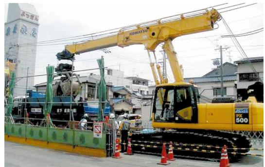
写真8 地下鉄工事現場で稼働中のPX500
