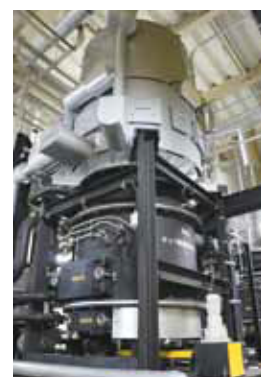
バイオマス蒸気ボイラ Biomass steam boiler
