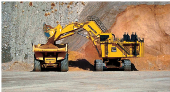
【無人専用運搬車両に積み込み作業を行う 超大型油圧ショベル PC7000-11】
