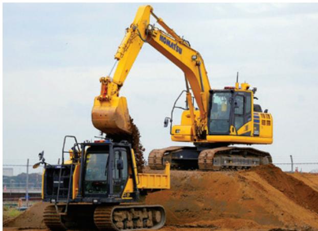
【自律稼働油圧ショベルおよび自律稼働クローラードンプトラック】
