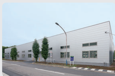
安全道場を併設する技能トレーニングセンタ Skills Training Center : Skill training and Safety Dojo
